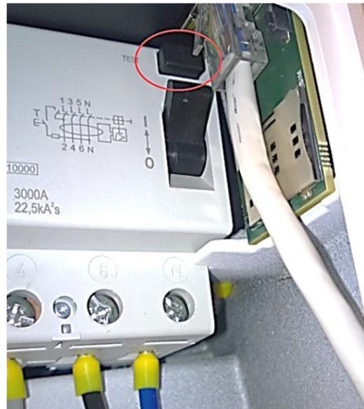
Rysunek 41: Przycisk testowy urządzenia RCD
