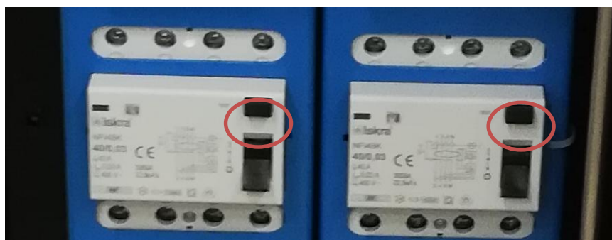
Slika 44: Gumb za testiranje FID stikala (RCD)
