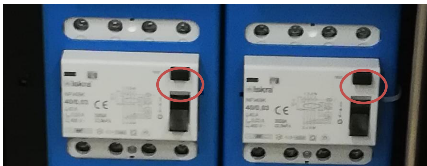
Rysunek 44: Przyciski testowe wyłącznika różnicowoprądowego
