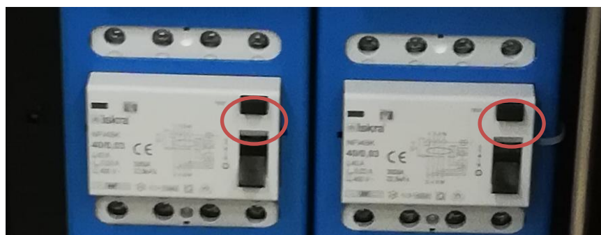
Immagine 44: Pulsanti di test RCD
