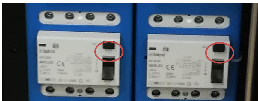
Kuva 44: Vikavirtasuojakytkimien testipainikkeet
