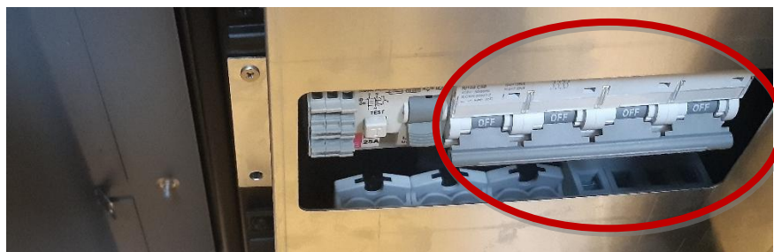
Abbildung 31: Der Haupt-Leistungsschalter kann zum Zurücksetzen der Ladestation verwendet werden
