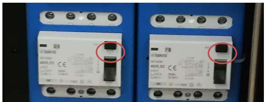
Abbildung 30: Fehlerstromschutzschalter-Testtasten
