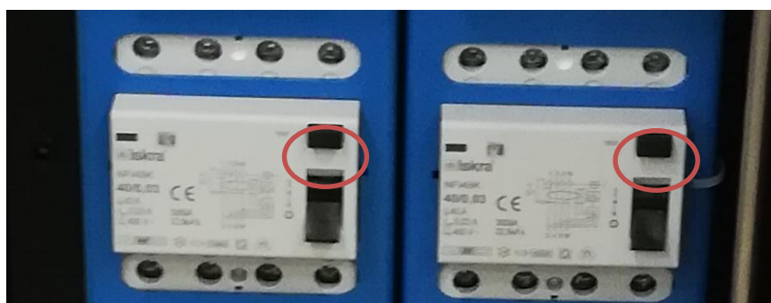
Figur 44: RCD (fejlstrømsanordning)-testknapper
